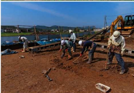
3. 人力掘削状況
