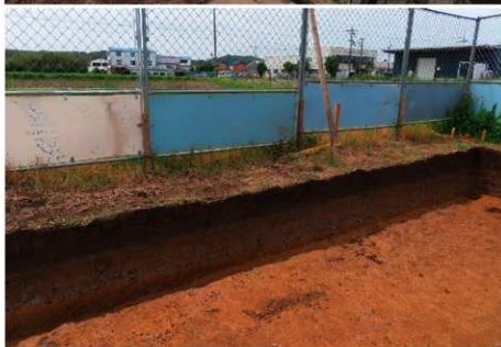
3. 西壁断面（北東から）
