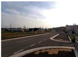
第7図 竣工後の調査地（東から）
