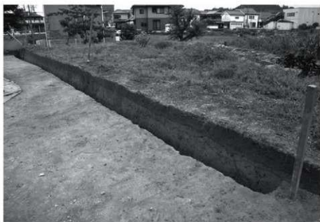
調査区西壁断面 (1) (北から)
