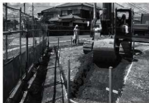
⑤機掘箇所状況（東から）
