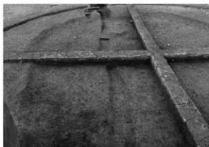
SD138 と SH120 の重複関係 (南から)
