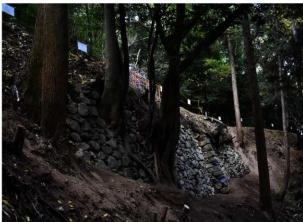
巻頭図2 石垣 69 全景 南東から
