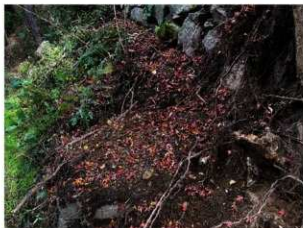
図 130 石垣付近での掘り返し(石垣 6・7)
