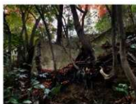
図 151 史跡指定地内にある擁壁
