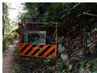
図 121 応急保護措置を施している 石垣(石垣 1)
