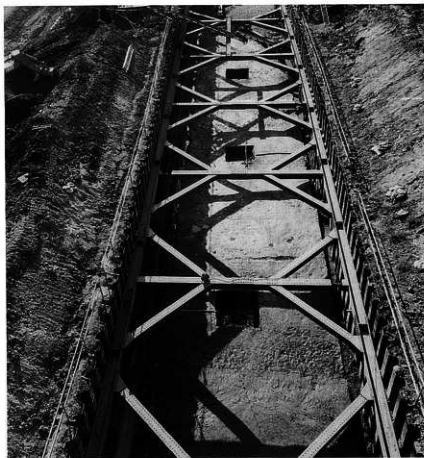
Aトレンチ 最終掘削面(手前)
