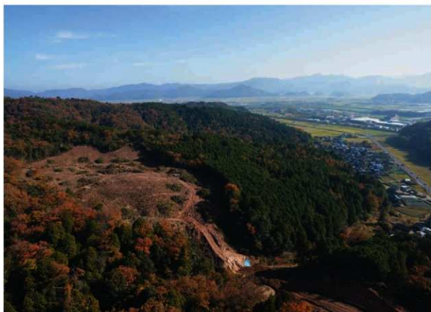
調査前遠景（西から）
