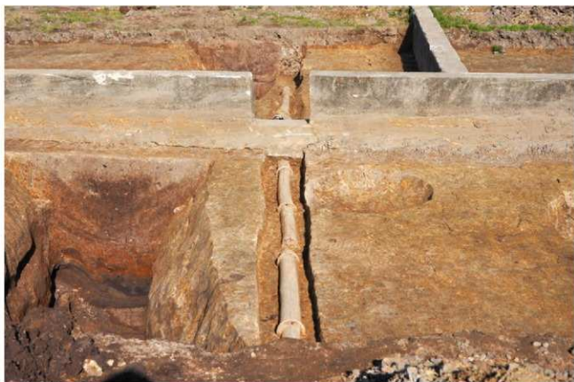
2 陶製土管出土状況 (南から)
