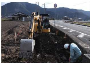
調査風景（機械掘削）
