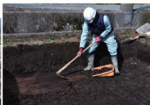
調査風景（人力掘削）
