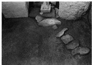
14号墳玄室内排水施設
