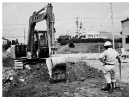
重機による表土除去
