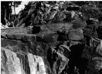
3 堀切西側の堀土上土留め石列
