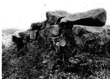
3 主郭東側石積 調査前状況 (北から)
