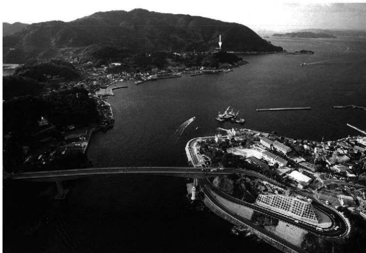
1 上関城跡遠景（河東 上関大橋上空から）
