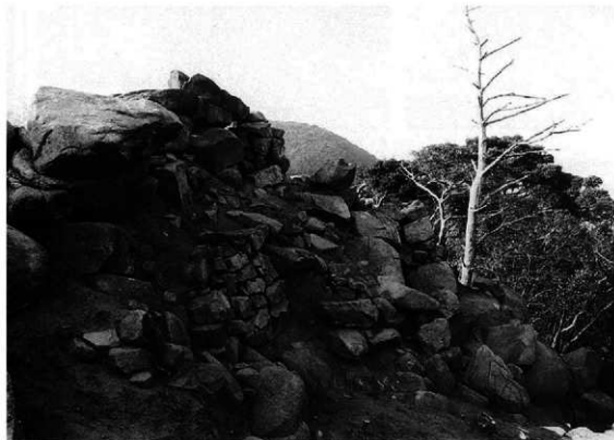
2 主郭東側石積 検出状況 (東から)
