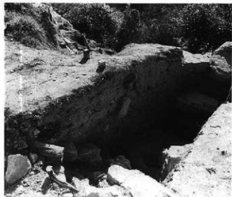
4 中央曲輪西側石積 裏込め状況B-B'（北東から）
