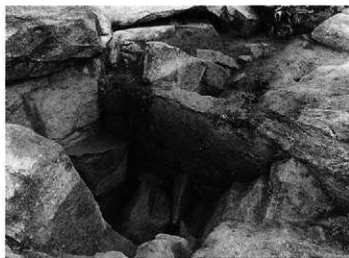
4 主郭東側石積 裏込め状況 (北西から)
