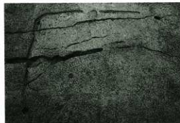
第99号住居跡 南東から
