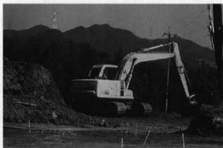
重機による表土除去
