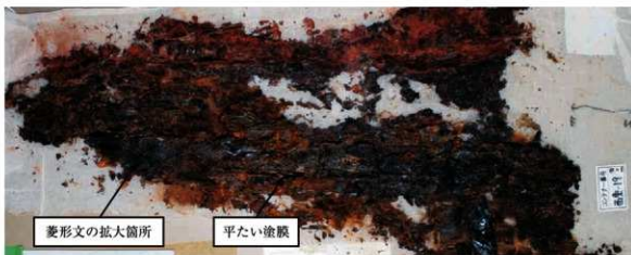
写真78 塗膜の拡大観察箇所写真(写真77はこの下層から剥ぎ取った部分)
