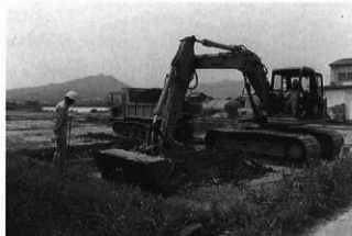
重機による表土除去
