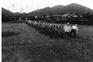
トレンチ掘り込み作業
