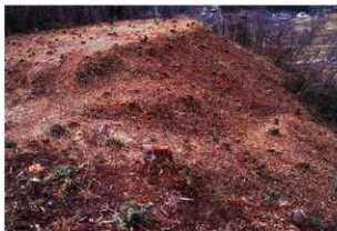
①北側斜面（北東から）
