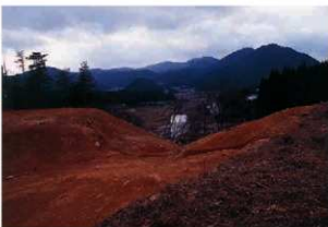
⑧掘割部分（南東から）
