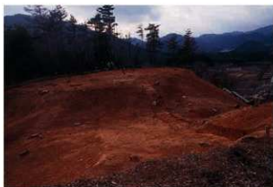
①掘割部分（東北東から）
