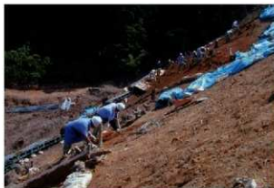
①北側斜面調査状況（西南西から）
