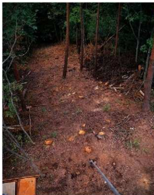
①T-③掘削前（東北東から）
