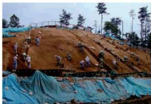
⑤北側斜面調査状況（東北東から）
