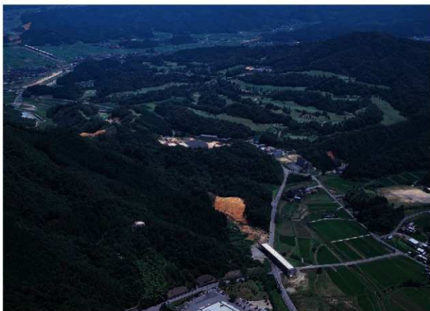
古墳近景（北西から・平成14年7月撮影）
