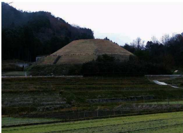
整備完了直前の墳丘（南西から）
