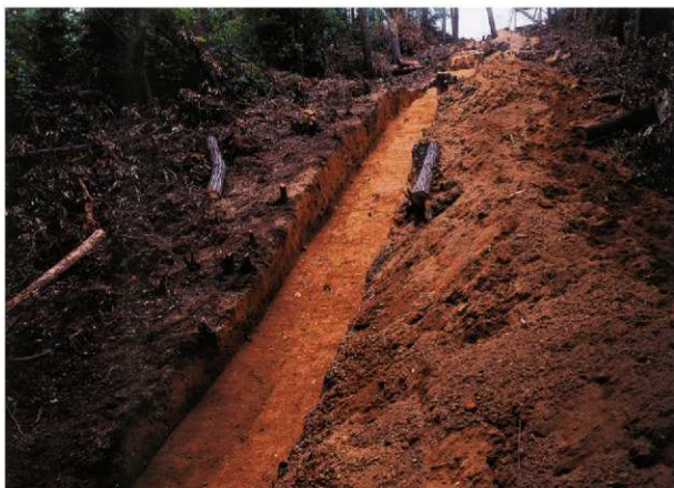
③T-③全景（南西から）
