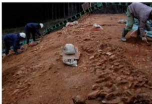
① 墳丘北西部斜面上端の葺石 (西南西から)
