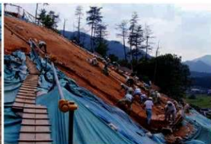
②北側斜面調査状況（東北東から）
