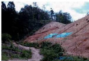
⑦道路用開削部境界線（西から）
