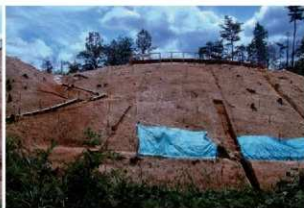
⑧道路用開削部境界線（西北西から）
