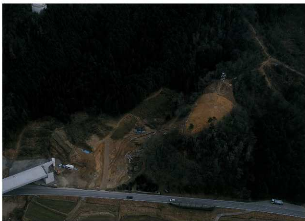
茶すり山郭遠景（南南西から）
