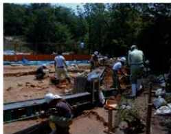
写真19 第1主体部拡張部の表土掘削風景
