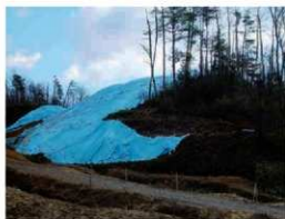
写真57 調査終了後の墳丘シート養生
