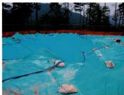
写真51 第1主体部の養生（3）
