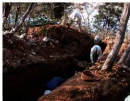
写真10 トレンチ掘削状況
