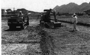
重機による表土除去作業
