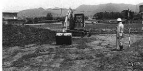
重機による表土除去
