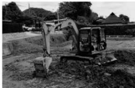
重機による表土除去作業
