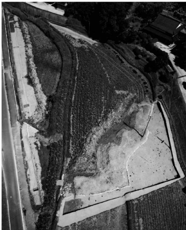
I地区全景（南東から）
