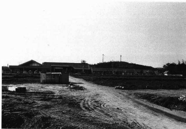
調査前風景（南より）
