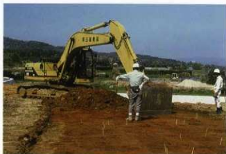
重機による表土除去
