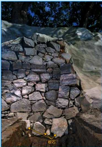
南側の石垣は掘り込みの處に直接根石を据えています。
