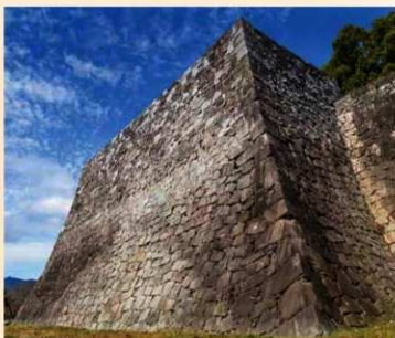
復旧が完了した天高くそびえる飯田丸五階櫓石垣
