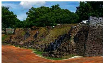
石材回収前の戌亥櫓周辺石垣
