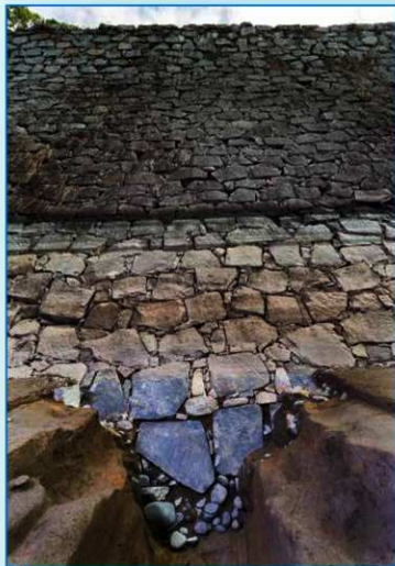
北側の飯田丸-要人櫓石垣は根石の下に丸い石を敷いています。
