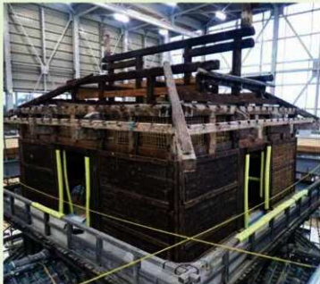
野地板が取り外された宇土櫓最上階
