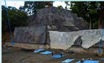
南西から見た発掘調査中の備前堀(写真奥は飯田丸五階櫓石垣)
