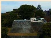
復旧が完了した飯田丸五階櫓石垣
