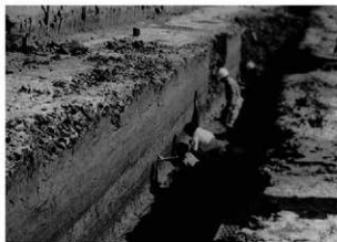
深掘トレンチ調査状況
