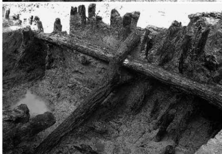
Y字支保材 (南西から)
