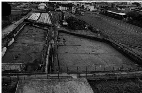
下層面全景 (西から)
