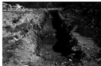
2トレンチ(南から)
