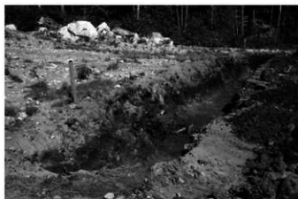
2トレンチ(西壁)
