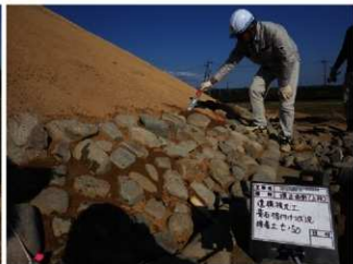
H30 遺構復元工 上段葺石据付け状況 (2)
