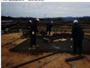
H30 園路舗装工 土質舗装施工状況
