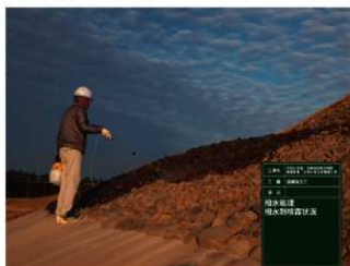
R1 遺構復元工 下段葺石工 撥水処理施工状況
