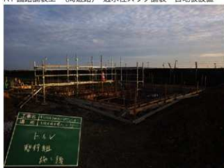
R3 トイレ 型枠組立後
