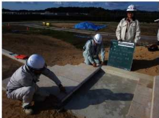
H30 階段工 C型階段 (テラス中段) 完成検査
