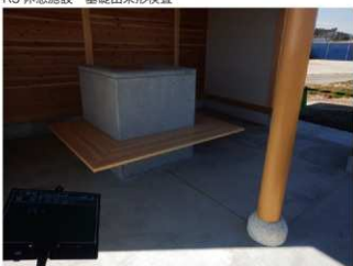
R3休憩施設 竣工 (2)
