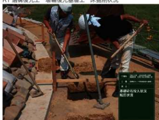
R1 遺構復元工 塙輪復元基層工 砕石投入及び転圧
