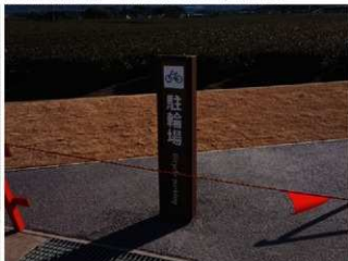
R4 管理施設整備工 駐輪場サイン施工状況
