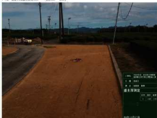
R4 造成工 敷地東端盛土工出来形
