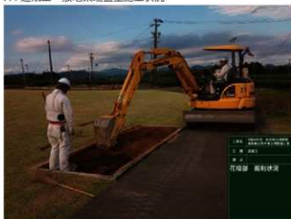
R4 園路工 花壇部掘削状況
