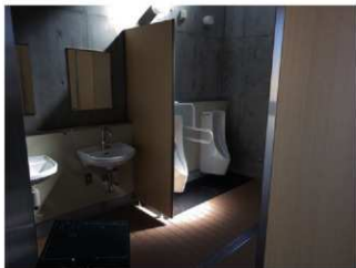
R3 機械設備工 竣工 (1)
