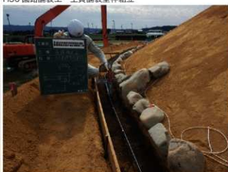
H30 遺構復元工 上段礫石（基礎石）基礎型枠
