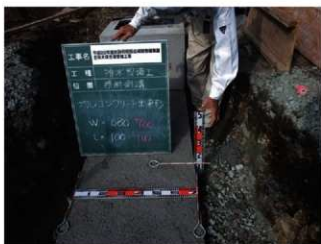
H29 排水設備工 均しコンクリート出来形
