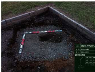
R4 管理施設整備工 解説板基礎碎石出来形測定
