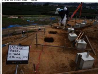
H30 管理施設工 ロープ柵基礎穴掘削状況
