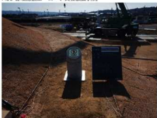
H30 管理施設工 立入禁止サイン設置完了
