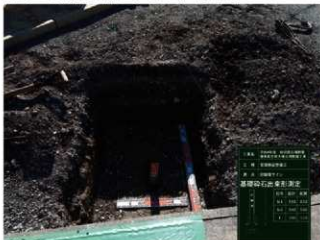
R4 管理施設整備工 駐輪場サイン基礎砕石出来形測定
