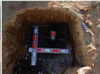
H30 管理施設工 ロープ柵基礎砕石
