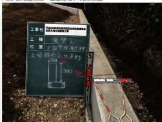
H29 敷地造成工 (擁壁工) 土塁縁石 B 出来形
