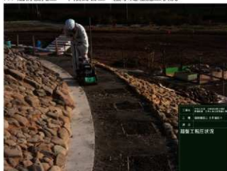
R1 園路舗装工 段架テラス (小段) 路盤工転圧状況
