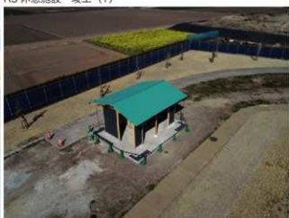
R3休憩施設 竣工 (3)
