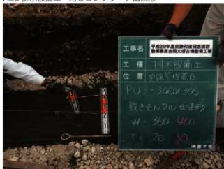
H29 排水設備工 敷きモルタル出来形 (史跡管理道 B)
