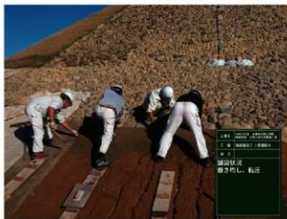
R1 園路舗装工 後円部法尻部 土質舗装 敷均し
