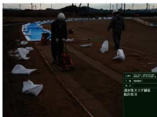
R1 園路舗装工（周遊路）透水性スラグ舗装 転圧状況
