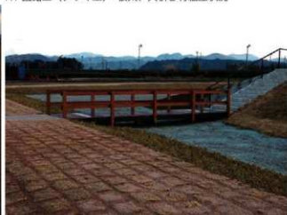
R1 園路工（デッキ工）設置完了
