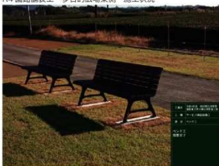
R4 サービス施設整備工 (ベンチ工) 設置完了
