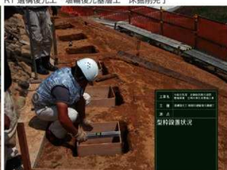
R1 遺構復元工 塙輪復元基層工 型枠設置状況
