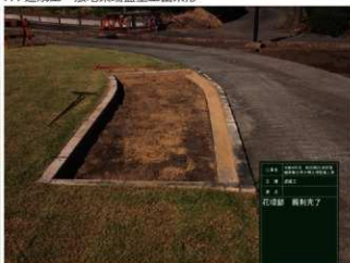
R4 園路工 花壇部掘削完了
