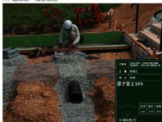
R1 排水設備工(暗渠工) 施工状況
