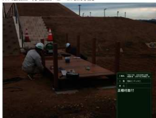
R1 園路工（デッキ工）高欄取付状況
