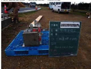
H30 管理施設工 ロープ柵基礎出来形
