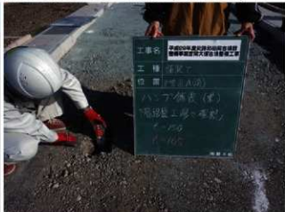
H29 舗装工 (ハンプ舗装下層路盤工) 完成検査
