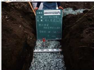
H29 雨水排水設備工 単粒度砕石出来形 (透水暗渠)
