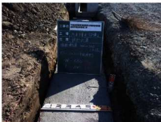
H29 雨水排水設備工 均しコンクリート出来形
