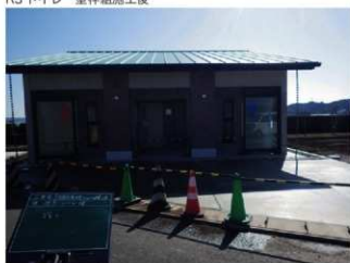
R3 トイレ 竣工 (1)
