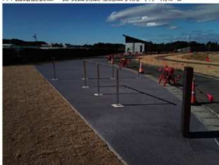
R4 園路舗装工 多目的広場東側 施工状況
