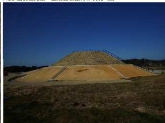
H30 遺構復元工 完成
