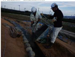
H30 遺構復元工 上段礫石（基礎石）基礎型枠コンクリート流し込み
