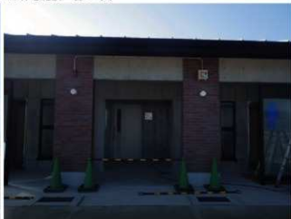
R3電気設備工 防犯カメラ設置
