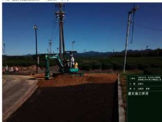
R4 造成工 敷地東端盛土工状況
