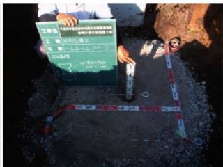
H29 電気設備整備工 ハンドホール工砕石基礎 (HH-1)
