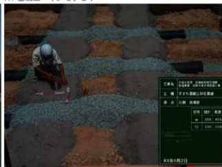
R1 階段工(手掘基礎工) 基礎碎石
