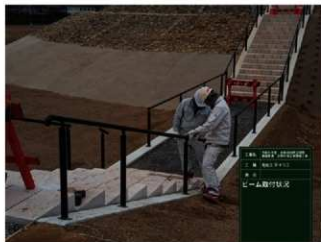
R1 階段工（手摺工）ビーム取付状況
