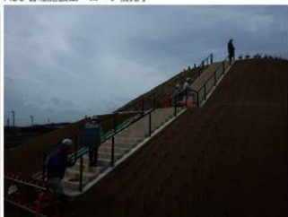
H30 管理施設工 手摺り 完成検査
