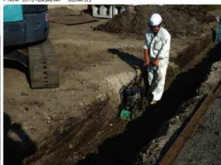
H29 排水設備工の様子
