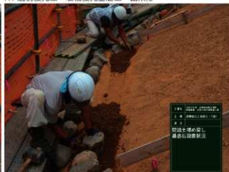
R1 遺構復元工 下段糞石工 基礎石設置状況
