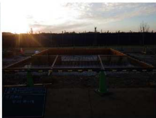
R3休憩施設 型枠施工後
