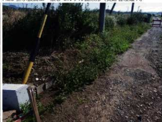
H29 排水設備工 施工前
