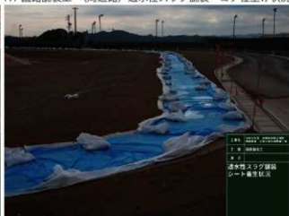
R1 園路舗装工（周遊路）透水性スラグ舗装 養生状況
