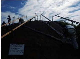
H30 墳丘造成工 暗渠排水材施工状況
