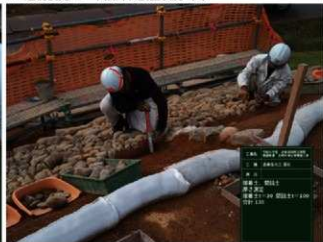
R1 遺構復元工 下段糞石工 間詰土施工状況
