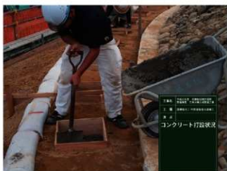
R1 遺構復元工 埴輪復元基層工 コンクリート打設状況
