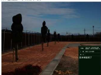
R1 植栽工 高木植栽出来形
