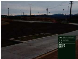
R1 造成工 多目的広場東側区画掘削完了
