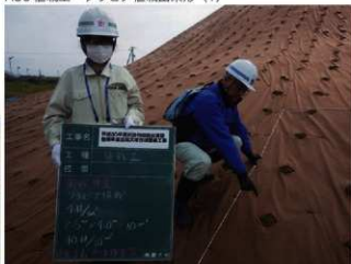
H30 植栽工 クラピア植栽 完成検査
