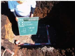
H29 電気設備整備工 引込柱基礎工砕石基礎
