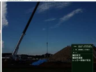
R1 園路舗装工 段架テラス (小段) 土質舗装 レッカー高揚/舟状
