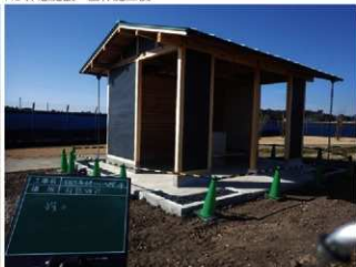
R3休憩施設 竣工 (1)
