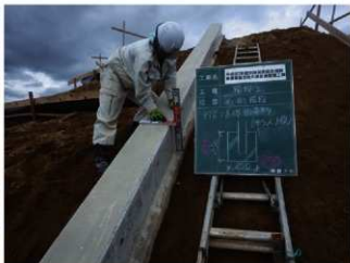
H30 階段工 手掘り基礎出来形 (テラス上段)
