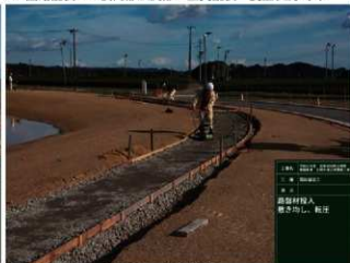
R1 園路舗装工 (周遊路) 路盤材投入
