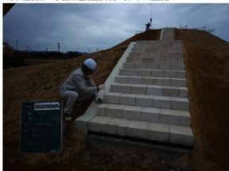
H30 階段工 B型階段出来形測定 (前方面)
