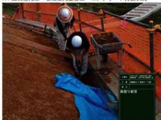
R1 遺構復元工 下段糞石工（基礎石）床掘状況
