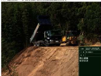
R1 造成工 残土処分状況
