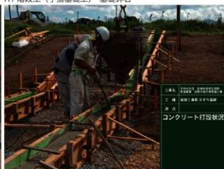
R1 階段工(手掘工) コンクリート打設状況
