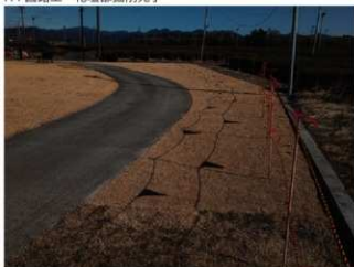
R4 植栽工 (張芝工) 敷地東端施工状況
