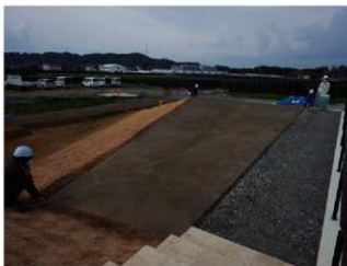
H30 園路舗装工 土質舗装 完成検査
