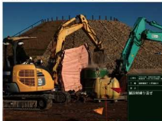
R1 園路舗装工 段架テラス (小段) 土質舗装 舗設材搬混ぜ
