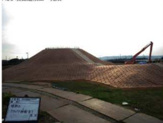
H30 植栽工 クラピア植栽出来形 (2)
