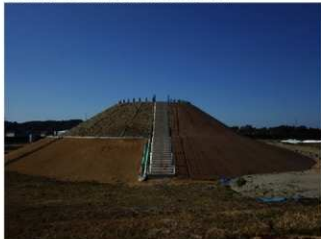
H30 階段工 竣工
