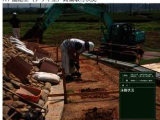
R1 遺構復元工 塙輪復元基層工 床掘削状況
