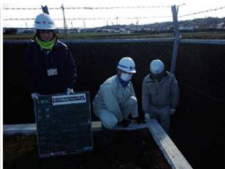
H29 敷地造成工 土塁縁石 A 完成検査
