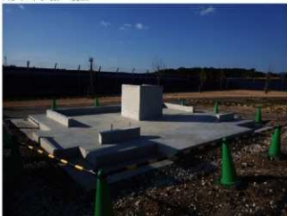
R3休憩施設 基礎出来形検査
