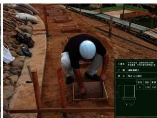
R1 遺構復元工 埴輪復元基層工 出来形
