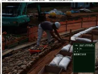
R1 遺構復元工 下段糞石設置状況（2）
