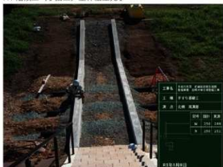
R1 階段工(手掘工) 北側周溝部分基礎状況
