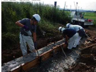
H29 敷地造成工の様子
