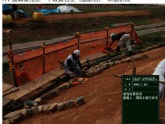
R1 遺構復元工 下段糞石設置状況（1）
