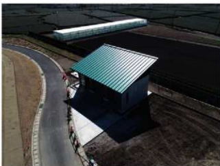
R3トイレ棟 竣工
