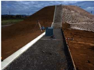
H30 園路舗装工 路盤材出来形 (前方面)
