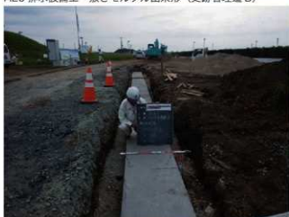
H29 排水設備工 横断側溝均しコンクリート
