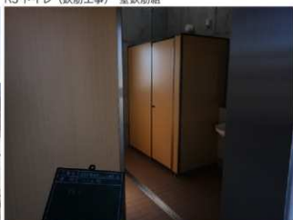
R3 トイレ 竣工 (2)
