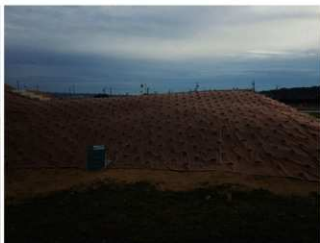
H30 植栽工 クラピア植栽出来形 (1)
