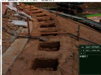
R1 遺構復元工 塙輪復元基層工 床掘削完了
