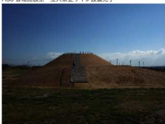
H30 管理施設工 竣工
