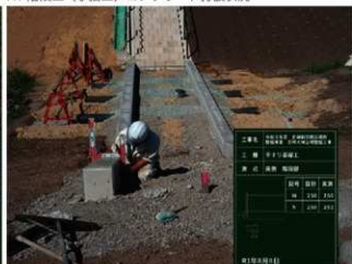
R1 階段工(手掘工) 南側階段部
