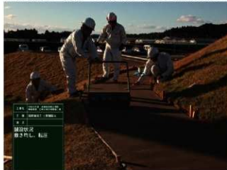
R1 園路舗装工 段架テラス (小段) 土質舗装転圧状況 (1)
