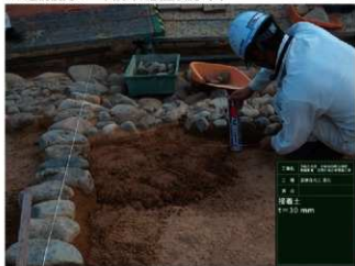
R1 遺構復元工 下段糞石工 接着土施工状況
