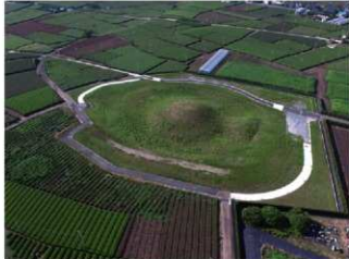
H30 工事着工前
