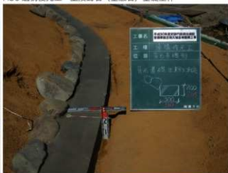
H30 遺構復元工 上段礫石（基礎石）基礎出来形
