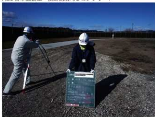
H29 排水設備工 (側溝工) 基準高測定
