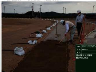
R1 園路舗装工 (周遊路) 透水性スラグ舗装 敷均し状況
