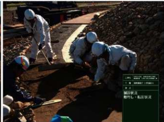
R1 園路舗装工 段架テラス (小段) 土質舗装転圧状況 (2)
