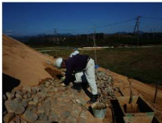
H30 遺構復元工 上段葺石据付け状況 (1)
