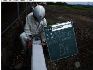
H29 敷地造成工 (擁壁工) 土塁縁石 B 出来形測定
