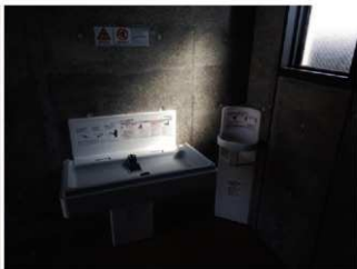
R3 機械設備工 竣工 (2)
