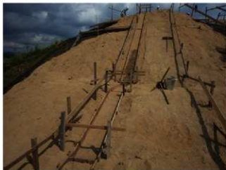
H30 階段工 丁張状況
