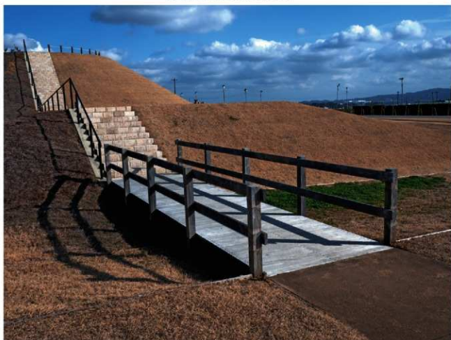
前部西端に設置されたデッキ園路
