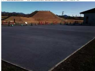
R4 園路舗装工 多目的広場西側 施工状況
