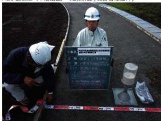
H29 舗装工（下層路盤）完成検査（史跡管理道B）(2)
