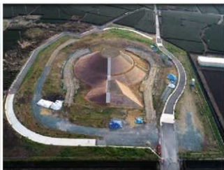
H30 園路舗装工 施工後西側
