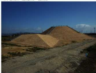
H30 植栽工 完成
