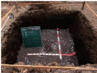
H29 電気設備整備工 ハンドホール工砕石基礎 (HH-2)
