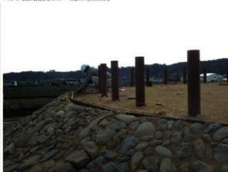
H30 園路舗装工 土質舗装型枠組立
