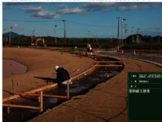
R1 園路舗装工 (周遊路) 型枠組立状況
