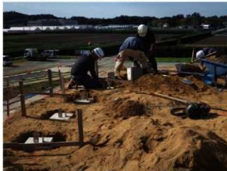
H30 管理施設工 ロープ柵基礎設置状況
