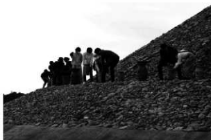
第101図 竣工式での埴輪設置
