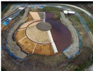
H30 園路舗装工 施工後東側
