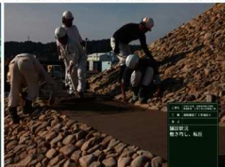
R1 園路舗装工 段架テラス (小段) 土質舗装状況
