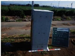
H29 電気設備整備工 引込柱基礎出来形
