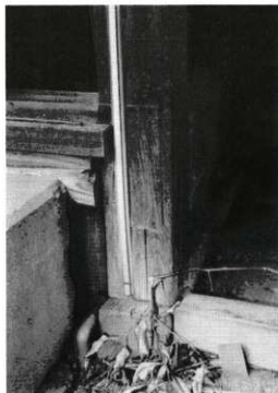
柱、ぬノ10に残る床の痕跡
