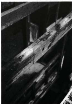
和釘で細工された軒桁
