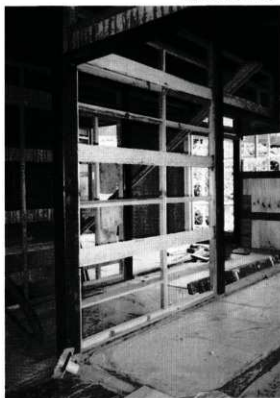
補強された壁下地
