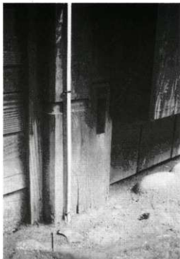
柱、ぬノ6に残る床の痕跡
