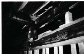
破損した出格子欄間
