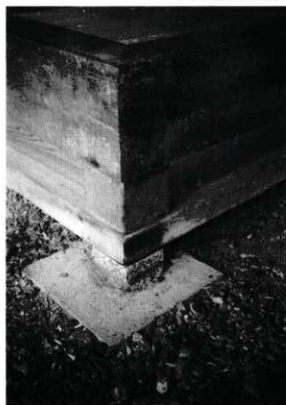
修理後の広敷の床
