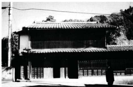
川坂屋正面全景(平成6年撮影)
