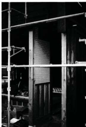
構造補強の為に追加した壁
