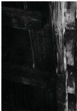
軒桁跡の残る垂木先端
