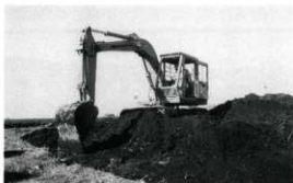
重機稼働風景
