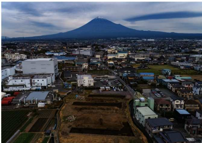
1. 調査区完掘遠景（南から）
