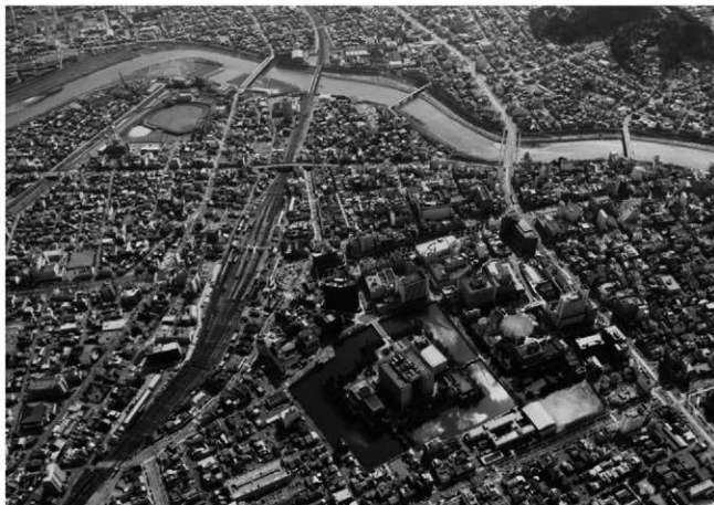
調査地遠景（北北東）
