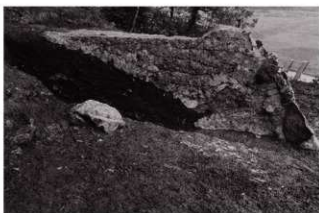
(6) 石垣2 断ち割り状況 (東方から)
