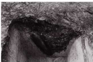
(6) 掘立柱建物2 柱穴15半載状況(東方から)
