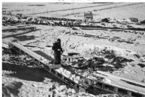
(4) 実測作業風景
