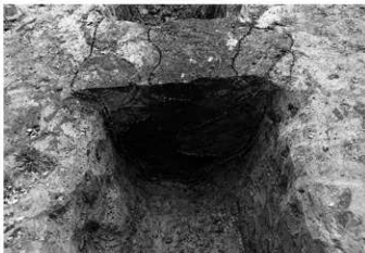
SD25 セクション 北西から
