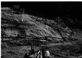
3. ベルトコンベアー設置
