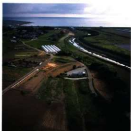
B2区(南から)
