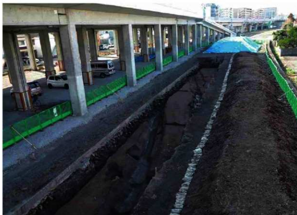
両側に側溝をもつ道路跡(SF024)
