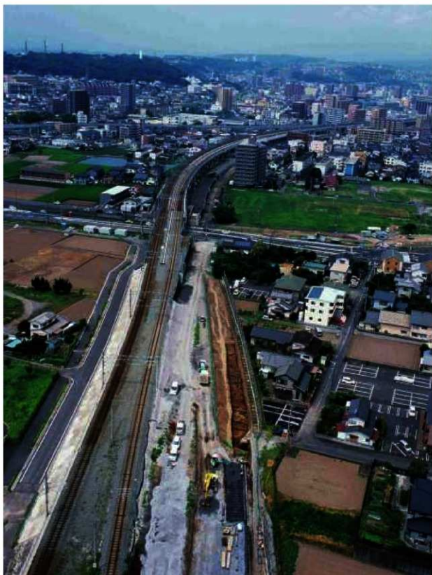
中世大友府内町跡第 96 次調査（東から）
