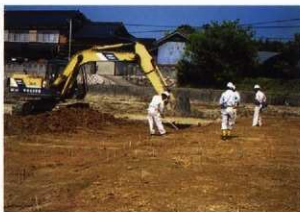
重機による表土除去
