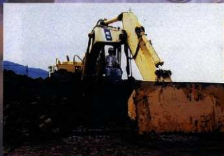
重機による表土除去作業風景
