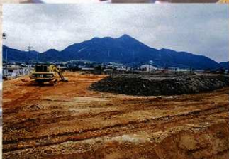
急ピッチで進むほ場整備工事
