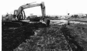
重機による表土除去作業
