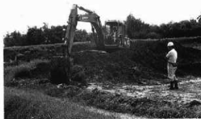
重機による表土除去
