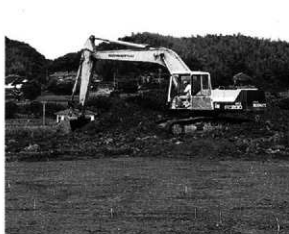
重機による表土除去
