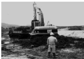
重機による表土除去
