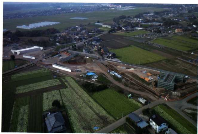
7次-2区 (南東から)
