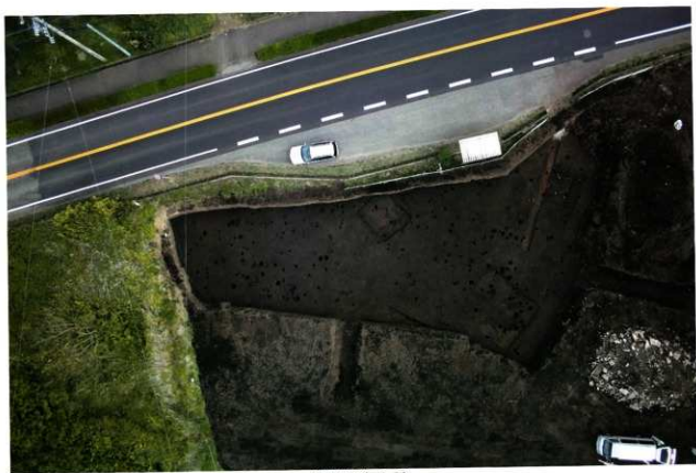
5次東半分（西から）
