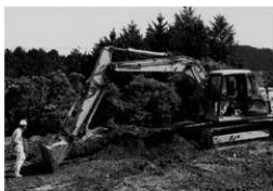
重機による表土除去
