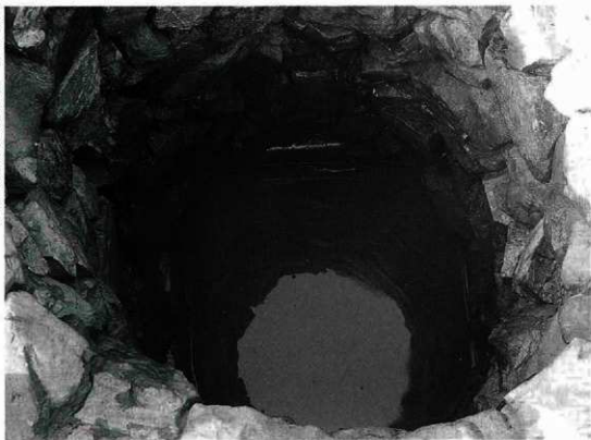
1. 井戸2 検出状況(東より)
