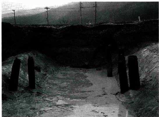
2. 南堀橋脚全景(東より)
