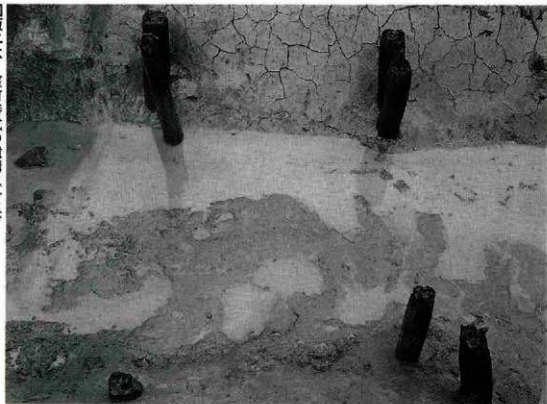
1. 南堀橋脚全景 (南より)
