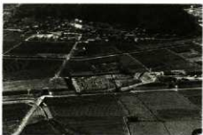
1. 遺構全景（東上から）
