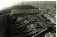
4. 旧河道の掘削
