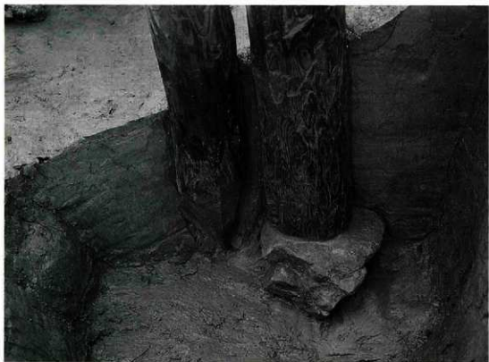
2. 南堀橋脚掘り方半截後断面
