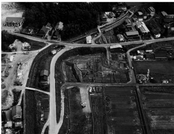
2面近景 (西から)
