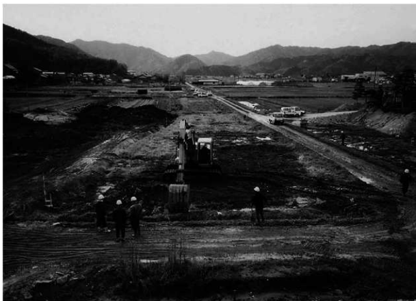
機械掘削状況
