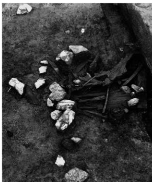
建物SB52003板材倒壊状況
