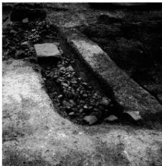
建物SB52003東辺基礎（北から）
