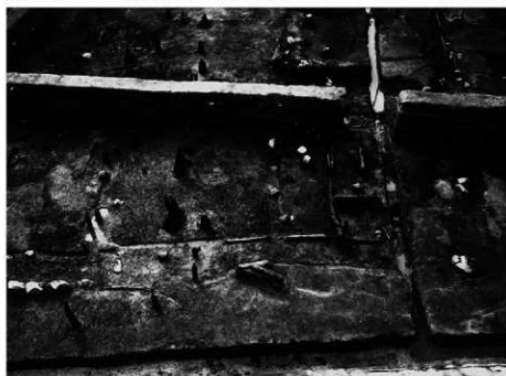
区画同上 近接 (東から)
