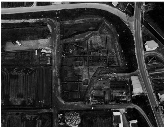
2面全景 (南から)
