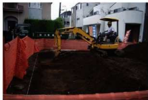
3. 表土剥ぎ風景
