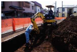
3. 表土剥ぎ風景
